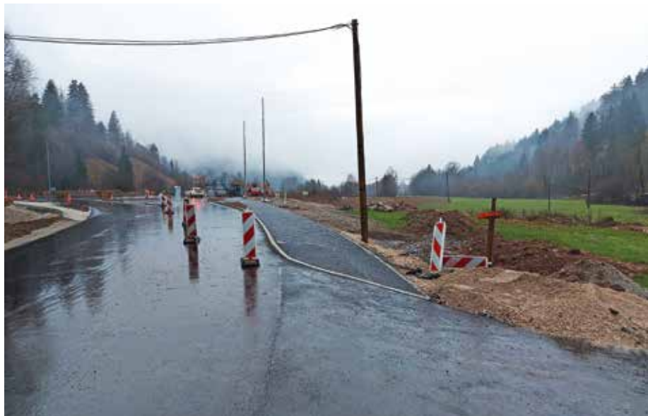
Novo obvozno cesto proti Logatcu so že asfaltirali. / Foto: Matija Podobnik
